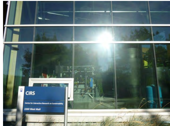
水処理システム
