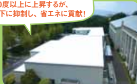
遮熱塗装 [アスリートジム屋根]
