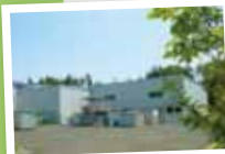
エコ・テクノロジー 研究センター外観
